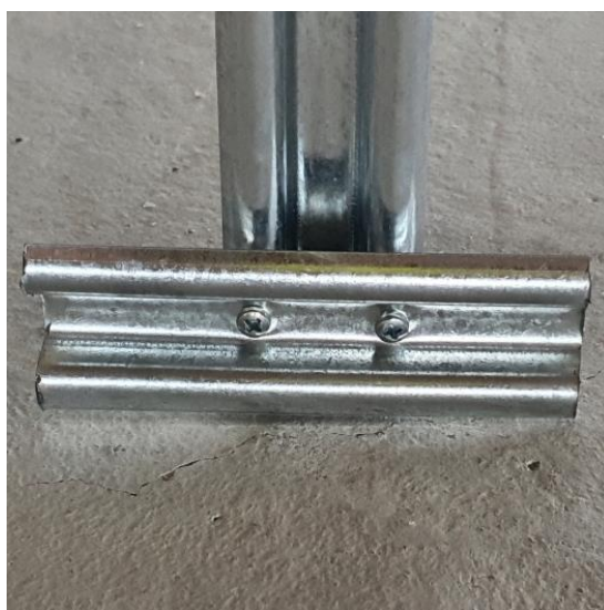
Obr. 2 - detail E (pohled zvenku skleníku)
